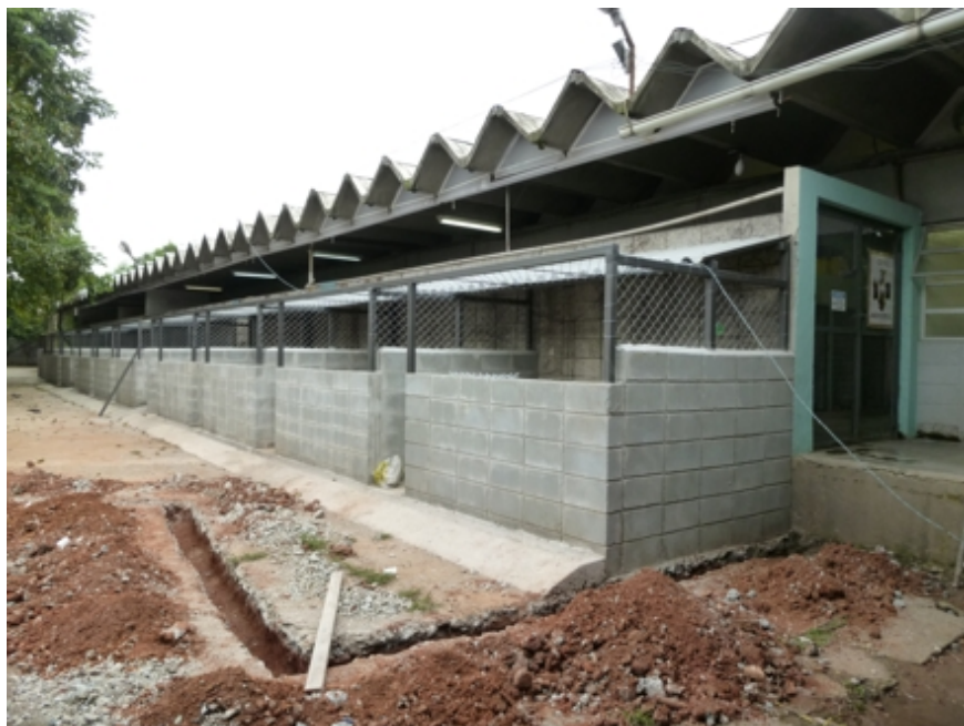
A obra dos solários na ala dos canis individuais. Foto: Regina Macedo
